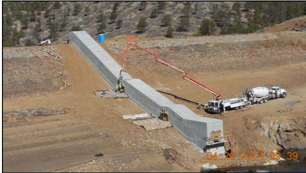
Final concrete pour at Nichols Dam (WCM photo)
